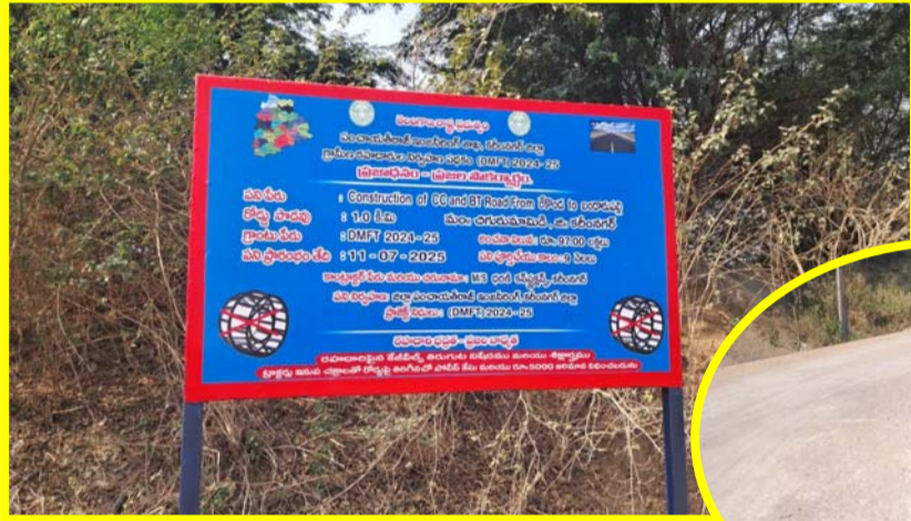
చిగురుమామిడి, జూన్ 12: ప్రజా ప్రతిభ కరీంనగర్ జిల్లా చిగురుమామిడి మండలంలోని రేకొండ గ్రామ పరిధిలో బండారుపల్లి దారిలో నూతనంగా నిర్మించిన సీసీ రోడ్డు ప్రజలకు వరం కాకుండా శాపంగా మారింది. కాంట్రాక్టర్ నిర్లక్ష్మం, అధికారుల పట్టణంలో రోడ్డు ప్రమాదాలకు నిలయంగా మారడంతో స్థానికులు తీవ్ర ఆందోళన వ్యక్తం చేస్తున్నారు.
